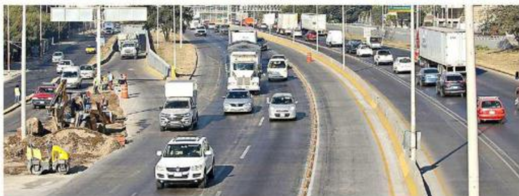
■ Las obras en el Peribús están por concluir; arrancaría a finales del mes.
